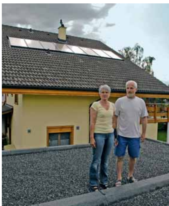
Heidi und Fritz Schneeberger mit den Solarkollektoren im Dach.
