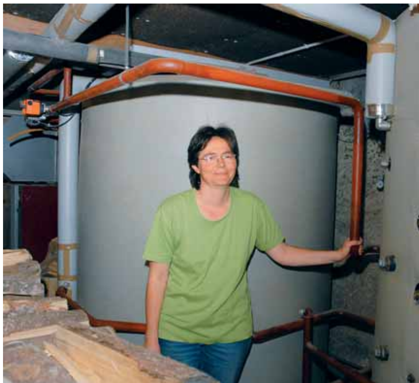
Tamara Matti im Heizkeller mit dem Stückholzofen (links) und den beiden Speichern.
