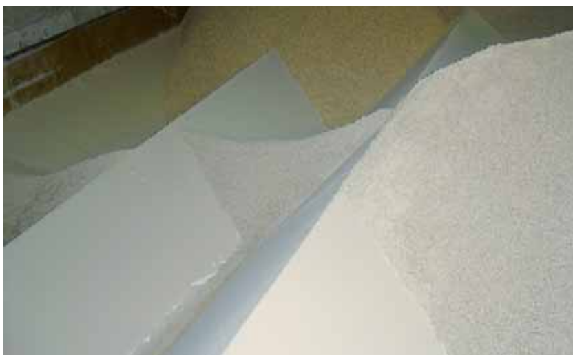
Schrägboden in Pelletslagerraum
